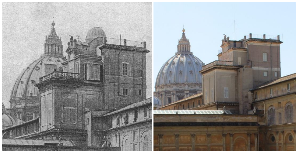
Figura 3.13 – Torre de los vientos hacia 1950. Se aprecia una pequeña cúpula en la parte superior.
