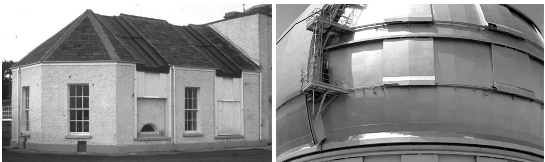
Figura 9.111 – Sistemas de ventilación controlada del Observatorio de Dunsink.
